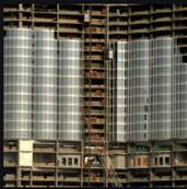
Foram usados mais de 26.000 painéis de vidro para revestir o exterior do Burj Khalifa. Foram trazidos da China mais de 300 especialistas em revestimento para o trabalho de revestimento da torre.
